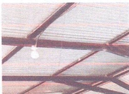
Foto 5: Cambio de plafoneras de los modulos
