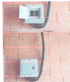
Foto 2: Cambio de la caja de 8 circuitos y los flípones.
