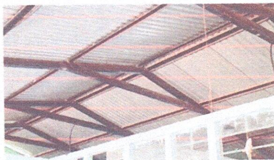
Foto 4: Cambio de cables en los modulos
